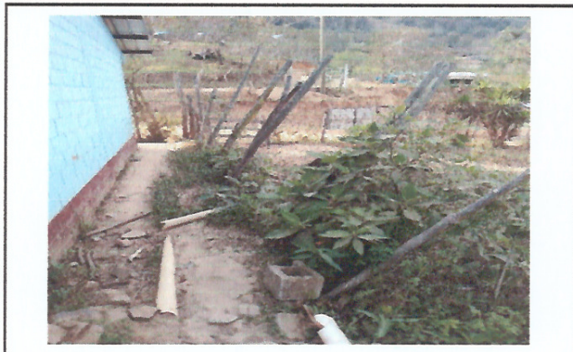
Foto 2: #-1. Mejoramiento de Cerco o muro perimetral.
