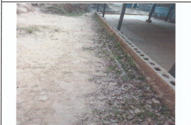
Foto 4: #-3. Mejoramiento de Cuneta de concreto.
