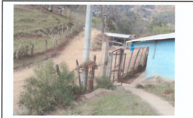
Foto 1: #-1. Mejoramiento de Cerco o muro perimetral.
