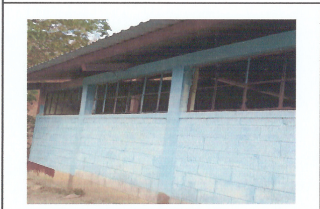
Foto 3: #-2. Mejoramiento de Ventanales.
